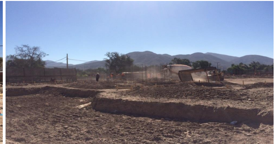
Proyecto Habitacional Las Vertientes II, T. Amarilla; 105 viviendas
