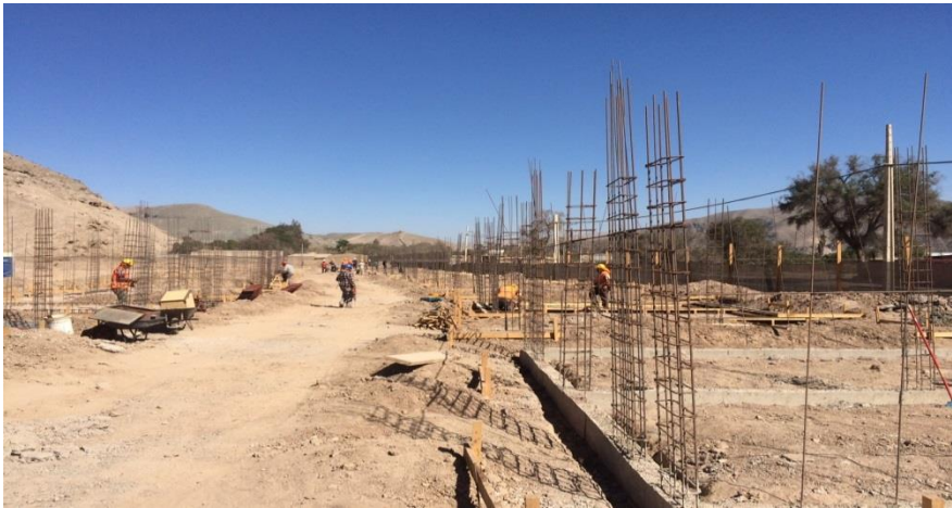
Proyecto Habitacional Las Vertientes I, T. Amarilla; 80 viviendas
