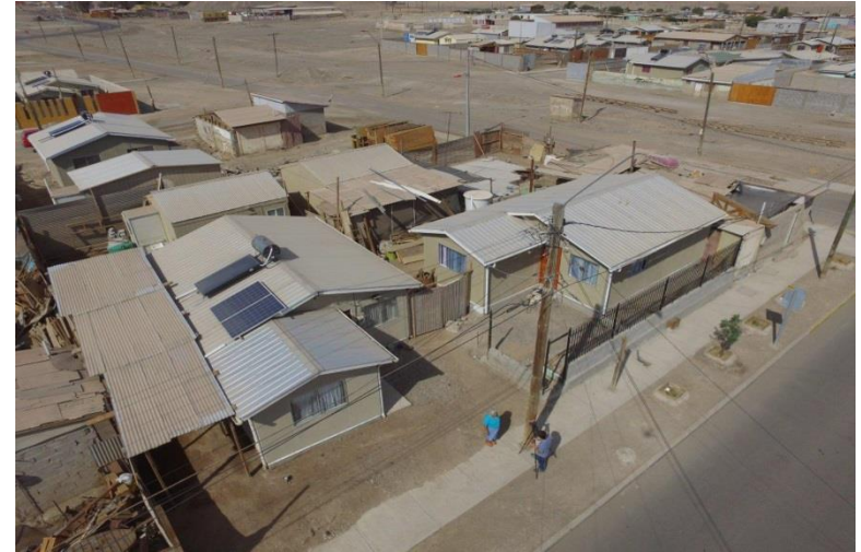
Construcción Sitio Propio, Diego de Almagro
