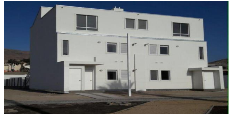
Vivienda Piloto CNT Chañaral
