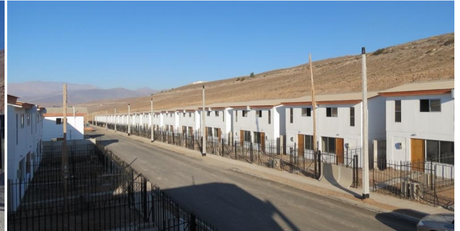
Proyecto Habitacional Nueva Castilla, Vallenar; 155 viviendas
