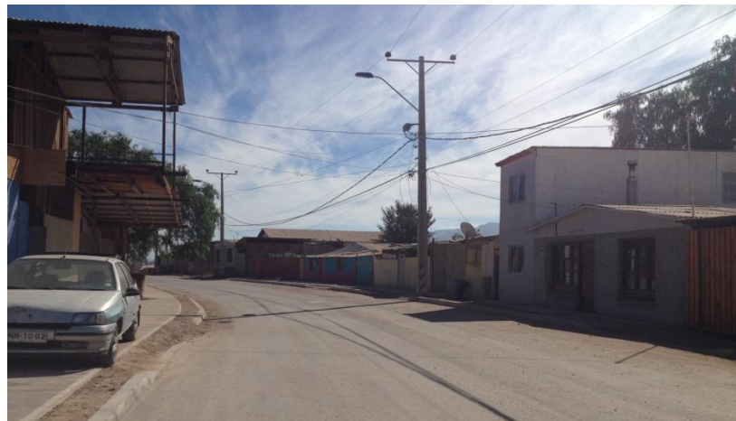
Construcción de obras de Urbanización Campamento Villa el Cerro, Copiapó; 133 familias
