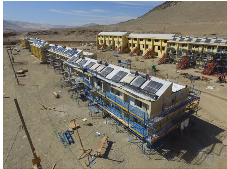
Vista Panorámica CNT 26 de Octubre
